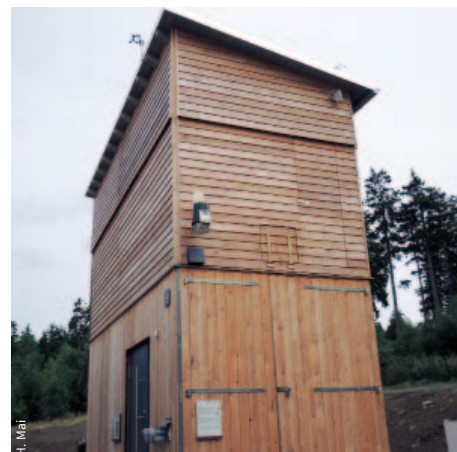
Die Holzpellets-Heizung ist in einem Energieturm neben dem Hauptgebäude untergebracht.
