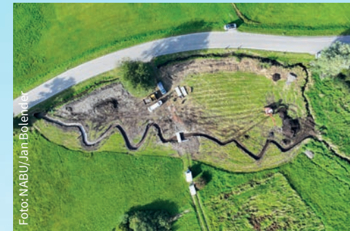
Renaturierung zwischen Vogt und Röttenbach: Der Mollenbach.
